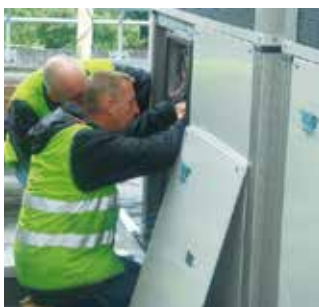
The National Grid's. Telefonos ügyfélszolgálati központ felújítása. Hinkley, Egyesült Királyság. ECO G
